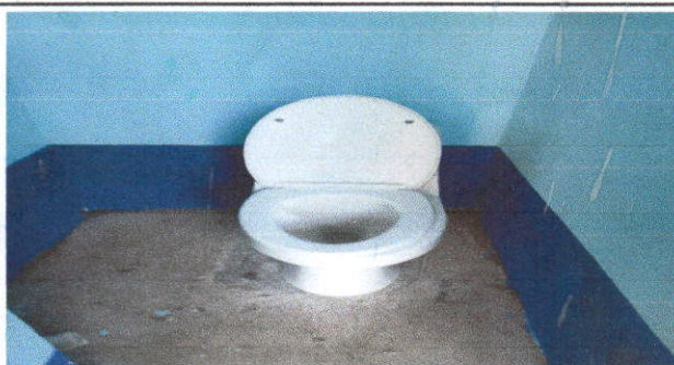
FOTO 5: SUSTITUCIÓN DE INODOROS
