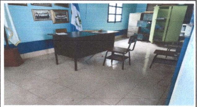
FOTO 4: REPARACIÓN DE PISO CERÁMICA
