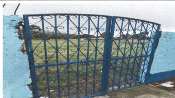
FOTO 3: SUSTITUCIÓN DE PORTÓN DE METAL
